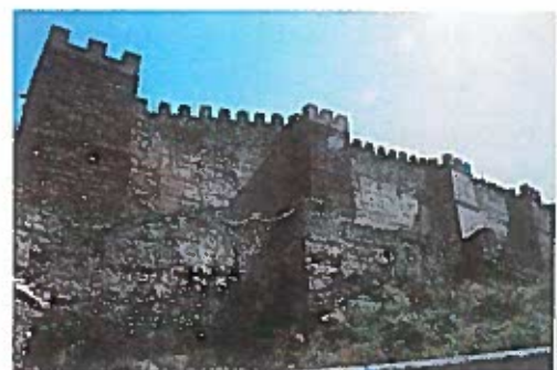
El muro de cierre meridional y el antemuro que lo defiende, al oeste de la Torre del Reloj.
